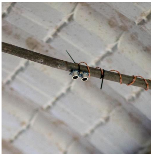
Figura 3. Instalação do sensor na parte superior da passarela
