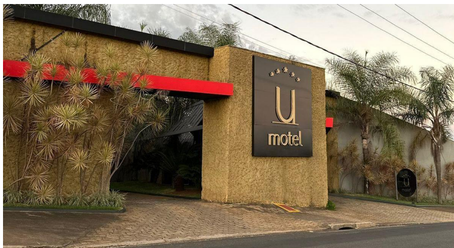
Figura 1 - Fachada do U Motel
