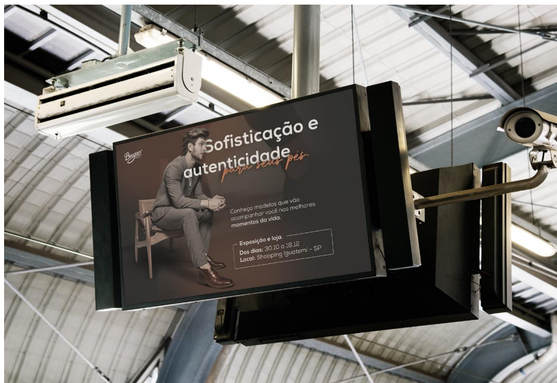
Figura 77 - Painel de LED aeroporto antes do evento aplicado
