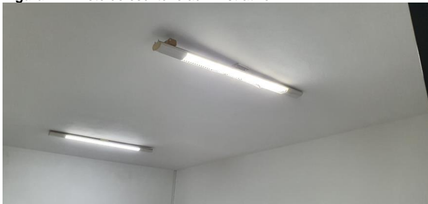
Figura 11 – Teto do escritório administrativo.
