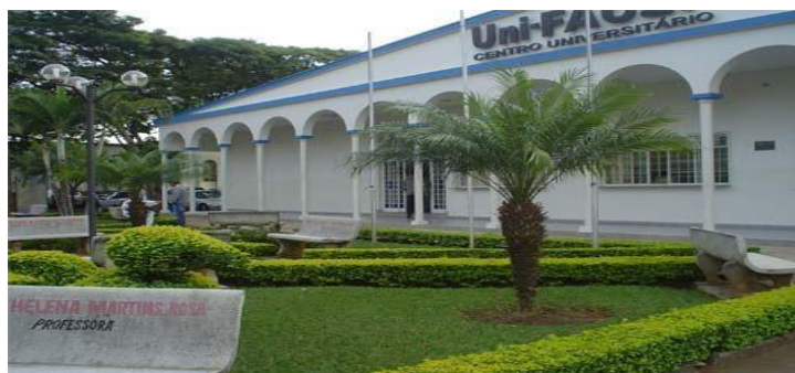
Figura 2 - Atual fachada da unidade 1
